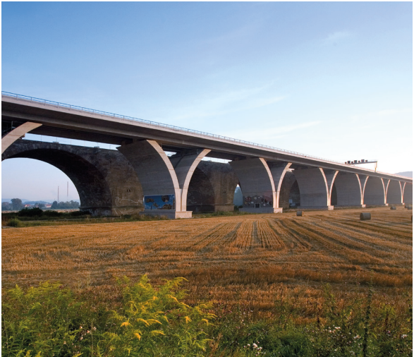
Saaletalbrücke bei Jena-Göschwitz | © Foto: Ingenieurbüro Kleb GmbH
